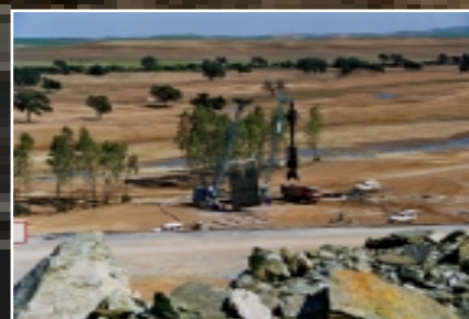
Utanför vallen är marken numera perforerad med dräneringshål. Längst ut byggs en barriär av polymerduk, som tätas med betongit.
