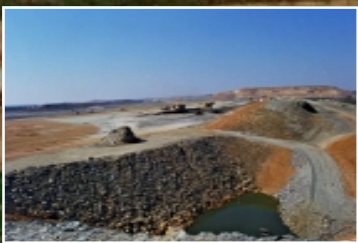
Brottet i dammen är provisoriskt tätat i väntan på domstolens utredning.
