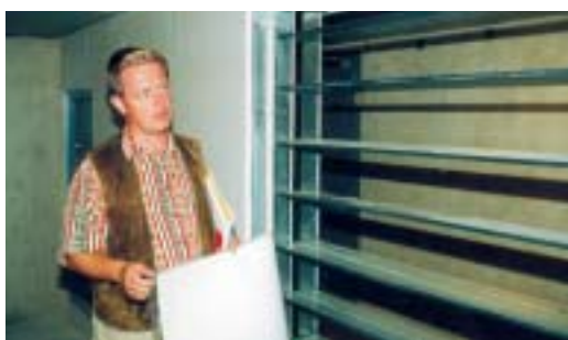
Ulf Carlsson, rektor, visar spjäll som reglerar flödet av tilluft.
