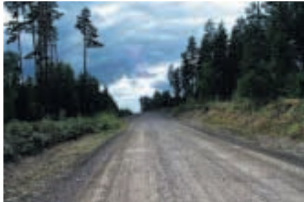
Grusväg utanför Uppsala byggd med torv/träaska.
