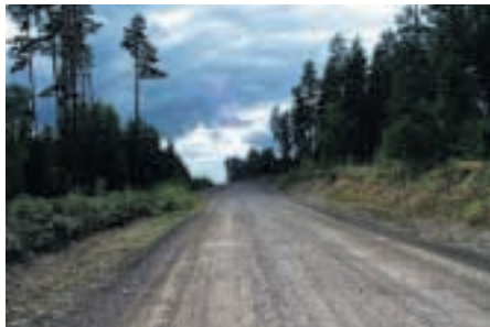
Grusväg utanför Uppsala byggd med torv/träaska.
