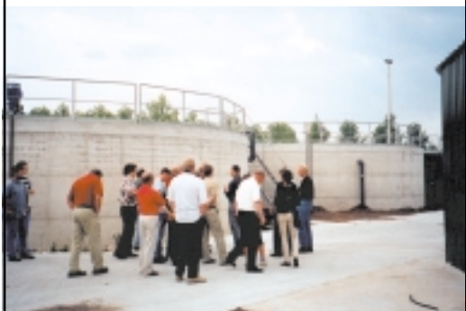
Lagertankar på biogasanläggningen, Padova.
