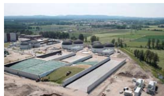
Impianto Schmack di produzione di biometano presso Schwandorf (Germania)
