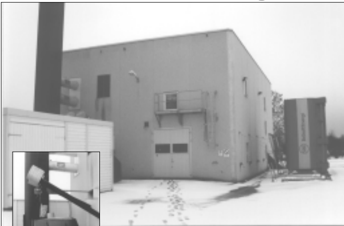
Till höger syns brikettcontainern som ställs på högkant och byts ut när den är tom. Till vänster syns askutmatningen med container.
