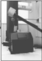
Till höger syns brikettcontainern som ställs på högkant och byts ut när den är tom. Till vänster syns askutmatningen med container.
