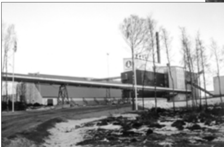
Vy över pelletsfabriken. Inkommande torkgasrör till processhuset. Byggnaden till vänster är färdiglagret.
