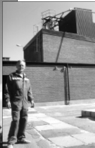
Den nybyggda delen av Orsa pelletfabrik.
