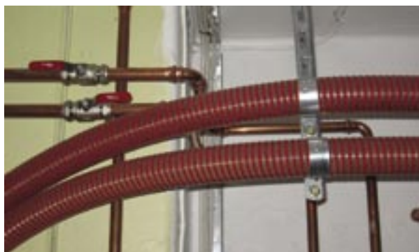
Sugslangar som transporterar pellets från garaget till pannan.
