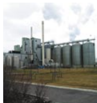
Etanolfabriken i Norrköping
