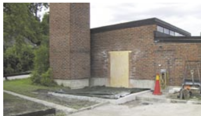
Tunagårds panncentral. Betongsulan där silon skall stå skymtar under pressningen. Uttaget i väggen är gjort för att ta ut och in gamla och nya pannor. Dessutom kommer pelletskraven att gå in där.
