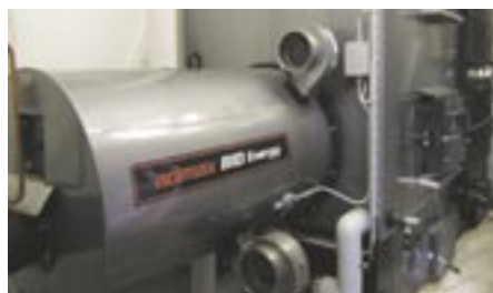
Stokerbrännaren från Arimax klarar flera typer av bränslen.
