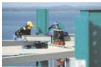
Omslagsbilden visar montagearbete på Skoghall. Foto tillhandahållet av Stora Enso
