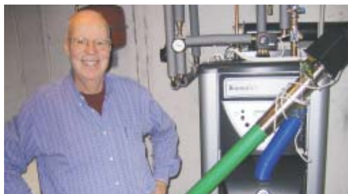
En felfri anläggning kan ge en så här nöjd kund och med bra kundkontakt får installatören reda på hur anläggningen fungerar.
