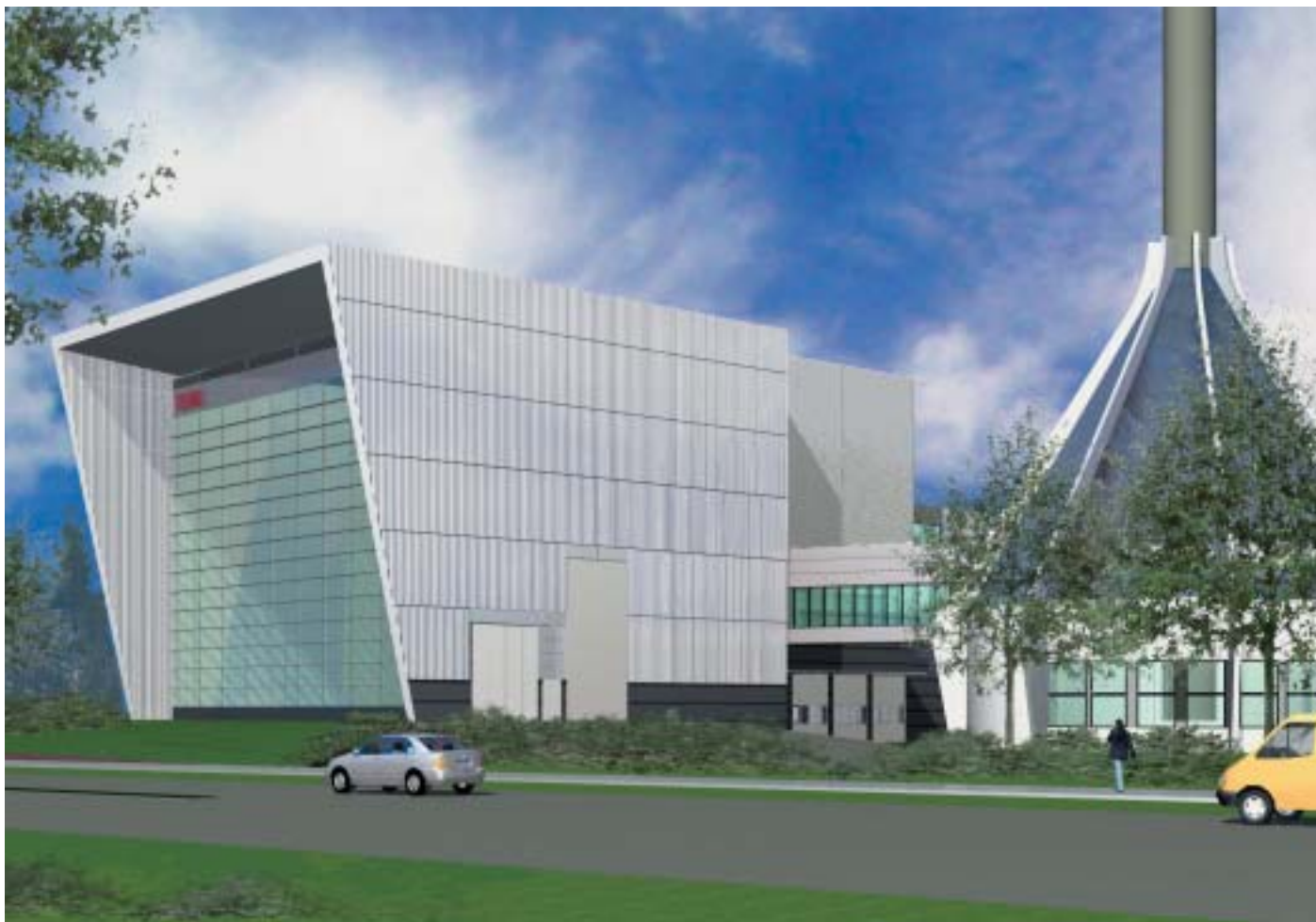
Det nya biokraftverket i Lextorp, Trollhättan, kommer att utrustas med en Wärtsilä BioPower 5 DH enhet.
