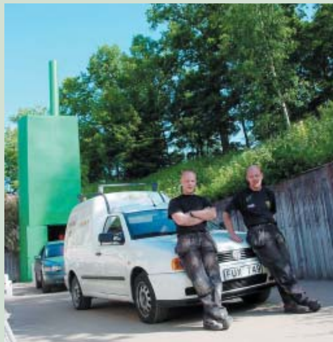
En närvärmecentral på 300 kW installerad och klar till Bostadsbolaget i Västervik.
