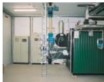
I Kärna installerades en 500 kW pelletpanna.
