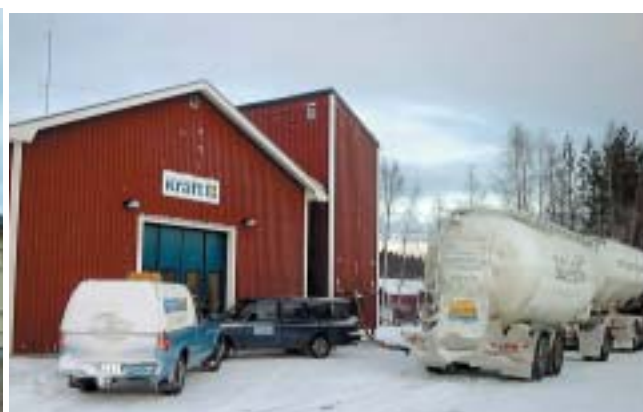
Närvärmecentral i Byske med två pannor på vardera 1,5 MW från Linka. Bränsleförråd två silos på vardera 30 kubikmeter i bakgrunden, värmeleverans cirka 8,5 GWh.
