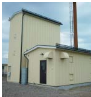
Närvärme i Bureå. Panna på 2 MW från Hotab i förgrunden. Parsilo på 2 x 40 kubikmeter.
