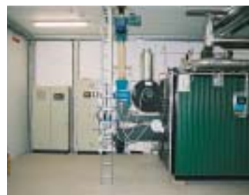
I Kärna installerades en 500 kW pelletpanna.
