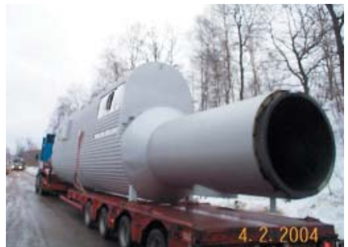
Leverans av reaktorn till rökgasreningssystemet.
