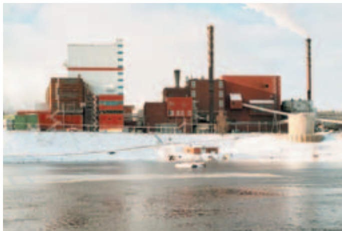
Papper- och massabruket i Kvarnsveden använder stora mängder el och värme för att tillverka cirka 700 000 ton papper per år. Pannhus med elfilter till vänster i bilden.
