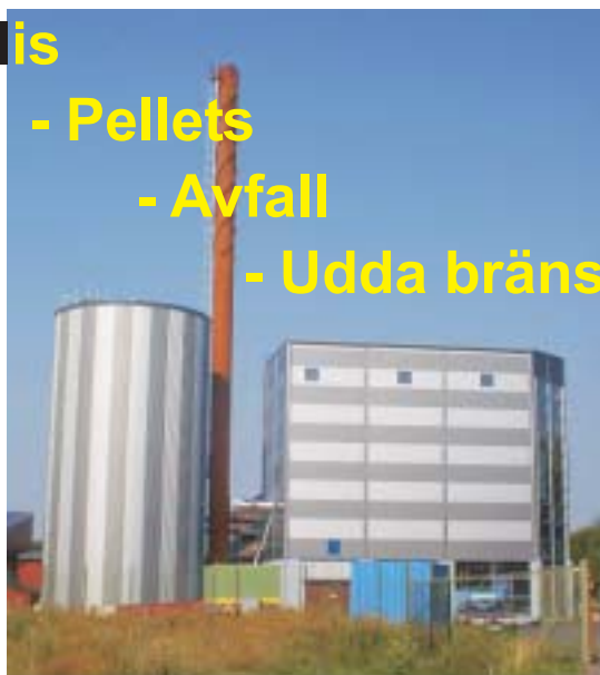
Ny teknik för avfallseldning demonstreras av TPS i Kil inom ramen för ett EU-projekt
