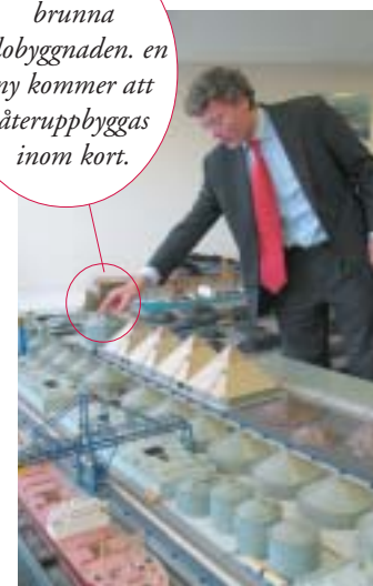
Modellen visar en del av hamnområdet som företaget EBS -bulkservice disponerar. En av de två stora på räls gående kranarna lossar eller lastar fartyget. Lasten läggs i en mindre utanpåliggande båt eller direkt till ett lager genom taket alternativt som i detta fall på det långa transportband som löper längs kajen och sedan tillbaka inmanför till de stora pyramidsilona.
