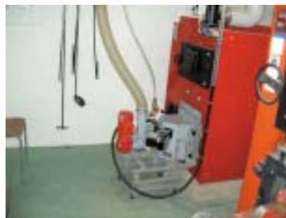
Det nya projektet i Hammerö med takintegrerade solpanelerna på två hyreshus av tre. Iwabo pelletbrännare och panna samt undercentral.
