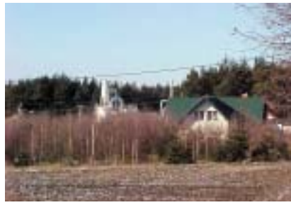
Anläggningen togs i drift i mitten av februari 2004
