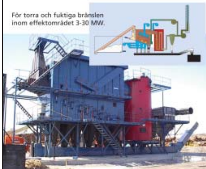
Montage Nyby Säg 12 MW.
