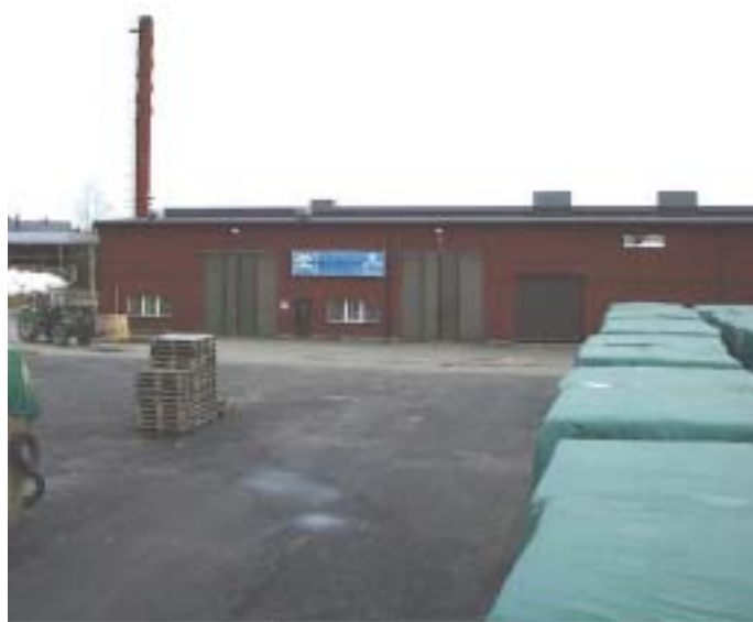
BTC anläggningen i Umeå inrymmer en fullskalig bränsleberedningsanläggning med rivare, blandningsutrustning, finkvarn, pelletspress och brikettpress. Vidare finns 3 försökspannor som även levererar värme till det lokala fjärrvärmesystemet samt utrustning för emissionsmätningar. I förgrunden försök med lagring av rörflenbalar.
