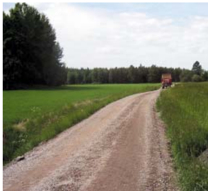
En lantbruksväg med torv- och träflygaska i förstärkningslagret.
