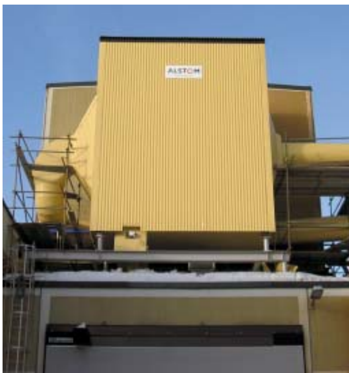
Installation av ett elfilter i en efter en barkpanna i Strömsund.
