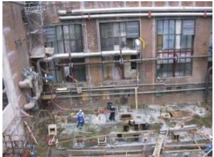
På platsen där den gamla avfallsförbränningsanläggningen stod byggs nu den nya.
