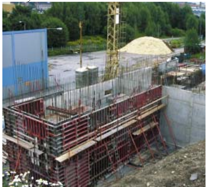
Bränslehanteringssystemet byggs upp.
