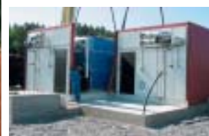
Anläggningen består av två ihopbyggda 3 MW panncentraler.
