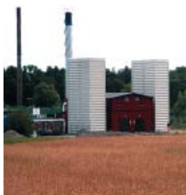
Anläggningen består av två ihopbyggda 3 MW panncentraler.
