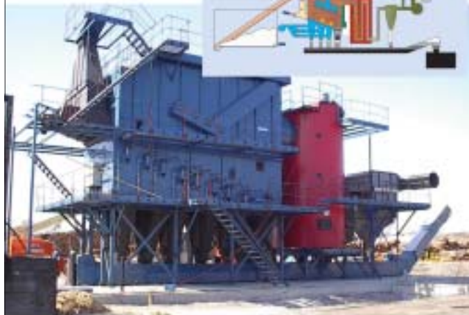
Montage Nyby Säg 12 MW.
