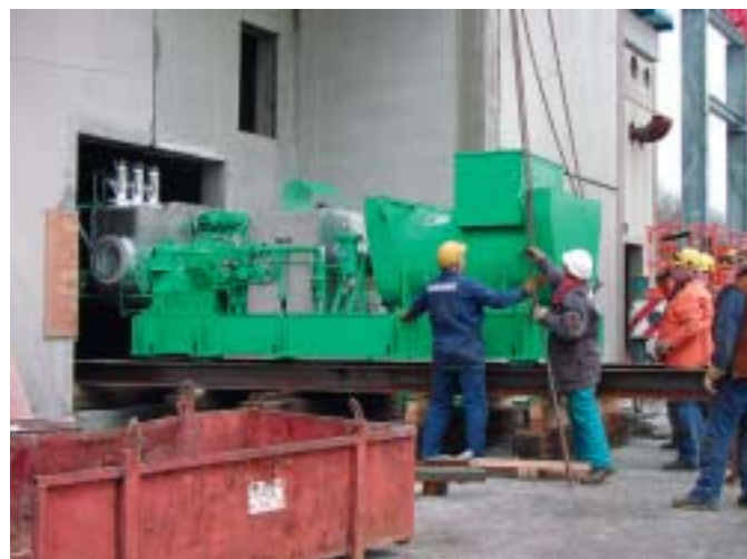
Ångturbin och generator levererar 1,4 MW el för eget bruk och som reservkraft vid avbrott.
