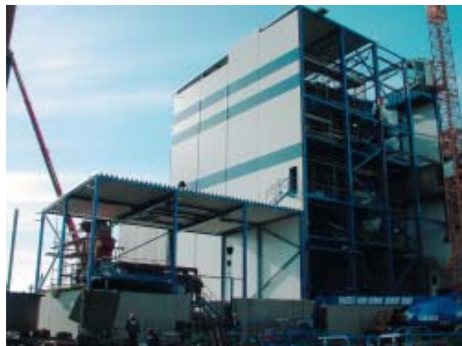
Pannan på 140 ton lyftes in i pannhuset i mars.
