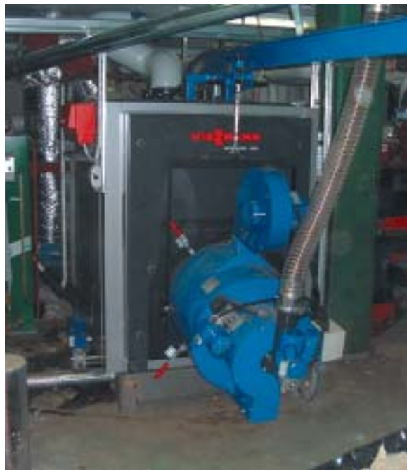
Jan fire Jet brännare för pellets installerad i en modifierad Viessman panna
