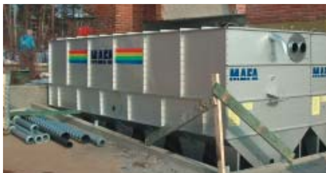
Två Mafa silos under uppförande före inbyggnad.
