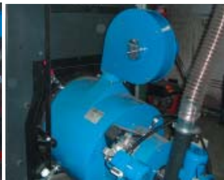
Jan fire Jet brännare för pellets installerad i en modifierad Viessman panna
