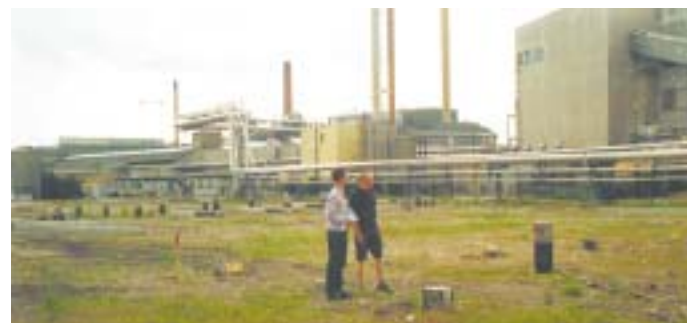
Platsen för pelletsfabriken i Køge som den såg ut i somras vid Bioenergis besök. Då hade endast pålningsarbeten inletts. I bakgrunden syns delar av Junkers Industrier.
