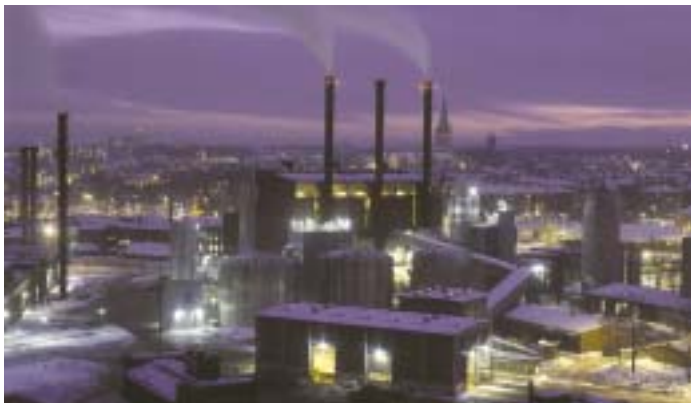
Kraftvärmeverket i centrala Linköping
