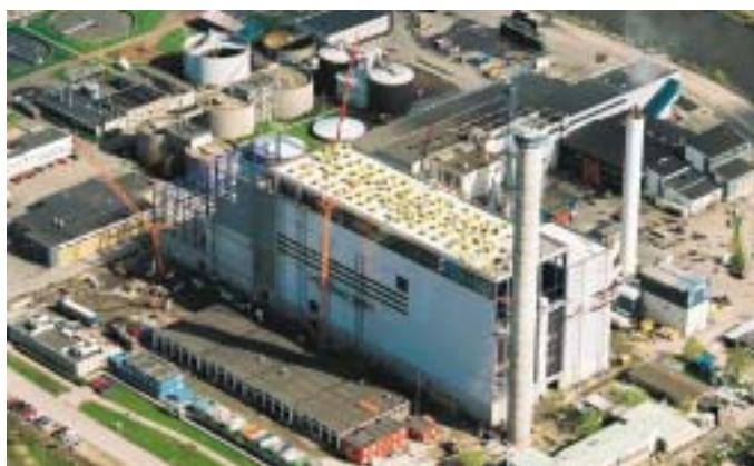
Flygfoto från i början av maj. Skorstenen är klar, glasning av fasaden och isolering av taket pågår.
