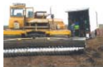
Basmaskinen under service. Den ägs av en entreprenadfirma som flyttar sig mellan mossarna.
