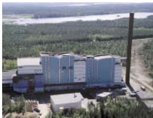
Dävaverket i Umeå är ett av världens mest effektiva förbränningsanläggningar för att utvinna energi ur avfall.
