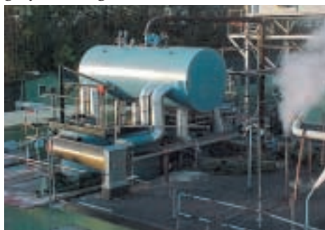
Pannan monterad. Som sista åtgärd lyfts pannhusets överdel på plats.
