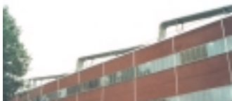
Bränslepulver blåses i 200 meter långa rör ovanför taket.
