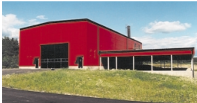
Rötningsanläggningen inryms i den stora röda byggnaden på infarten till "Tippen".
