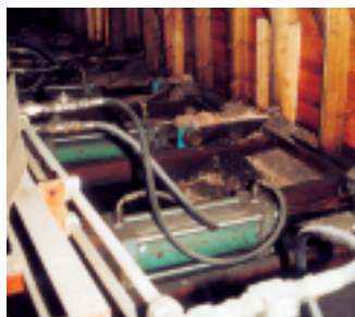
Hydrauliksystemet, det ligger tio på rad. De trycker 70 ton styck och drar 50. Med andra ord mycket rejäla prylar.
