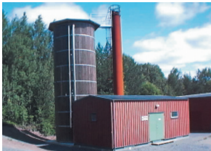
Portabelt pannhus med träpanel, utfört efter kundens önskemål av Hotabgruppen. Hotab tillverkar prefabricerade panncentraler i storlek från 100 kW upp till 2 000 kW.
