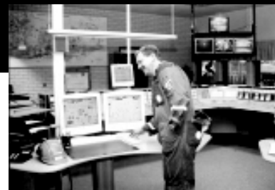
Inge Gottfridsson, driftingenjör på Västhamnsverket visar den nya styranläggningen från det österrikiska företaget SAT. I bakgrunden syns den gamla panelen som också är i drift.
