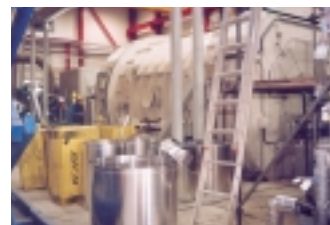
Bränslet förs upp på det långa inmatningsbandet från den stora A-silon till två mindre dagsilos i kraftvärmeverkets pannhus.
