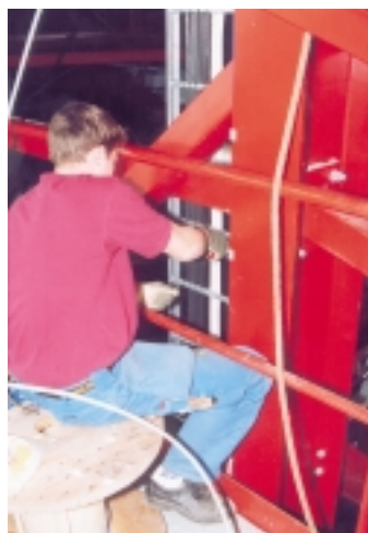
Kenneth Fordell som är elektriker kablar styrkablar. Han har arbetat vid bygget sedan i juni.
