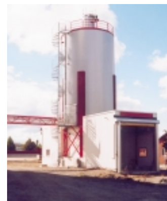
Anders Björklund på balkongen högst upp på pannhuset. Intill finns den stora ackumulatorn som möjliggör en jämnare energiproduktion trots snabba kast i värmebehovet. Bakom ser man ett närliggande villaområde som ligger på andra sida Eskilstuna ån. På ån gick tidigare kolpråmar till det gamla gasverket som fanns lokaliserat på samma ställe.
