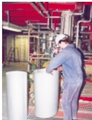
Jonas Grund arbetar med isolering
