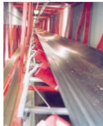
Bränslet förs upp på det långa inmatningsbandet från den stora A-silon till två mindre dagsilos i kraftvärmeverkets pannhus.
