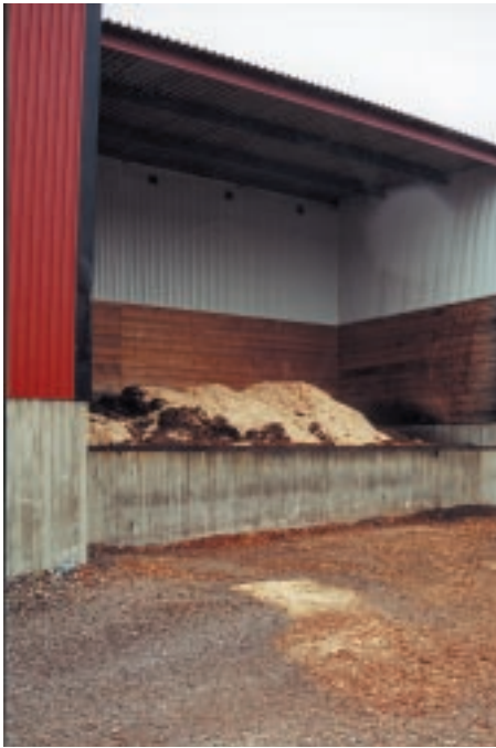
Bränslelager, våt mörk bark med torrflis att iblandas
