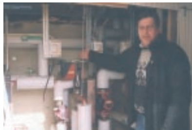
Bengt Erik Holmsten framför den till ackumulator ombyggda oljetanken
