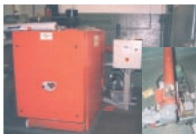
Pelletspanna med styrskåp samt infällt inmatningskruven.
