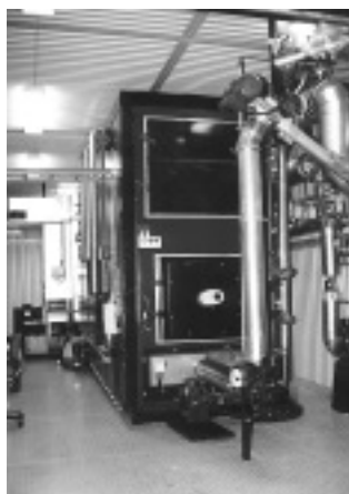
Anläggningen i Jörn, container lösning, reserven här är kundernas befintliga el och oljepannor.
